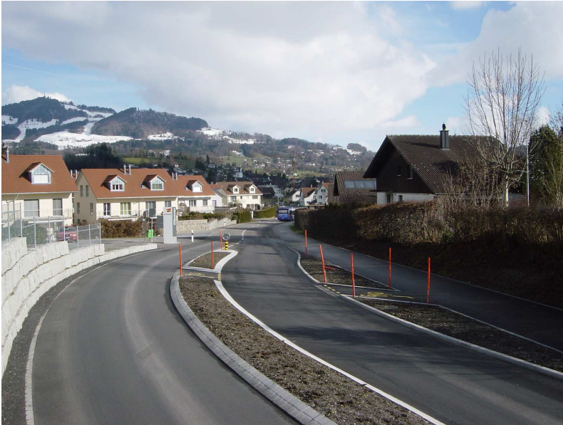
Bildlegende: Der Beginn des Rad- und Gehweges an der Dürnterstrasse – eine von mehreren Langsamverkehrs-Massnahmen, die in der Agglo Obersee bereits umgesetzt wurde
