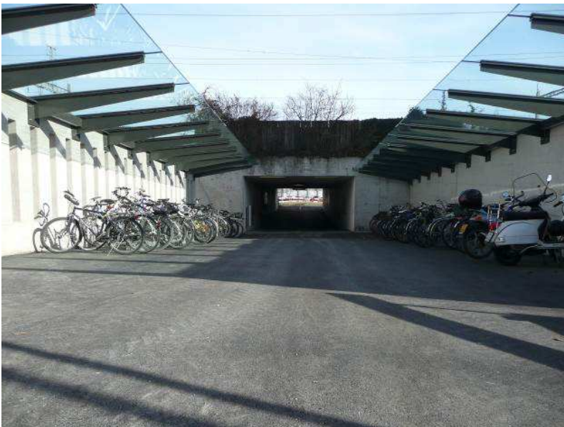
Bildlegende: Die neuen Veloabstellplätze am Bahnhof Bubikon – eine von mehreren Langsamverkehrs-Massnahmen, die in der Agglo Obersee bereits umgesetzt wurde
